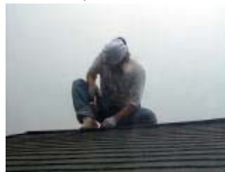
屋根 補修中の大工さん
